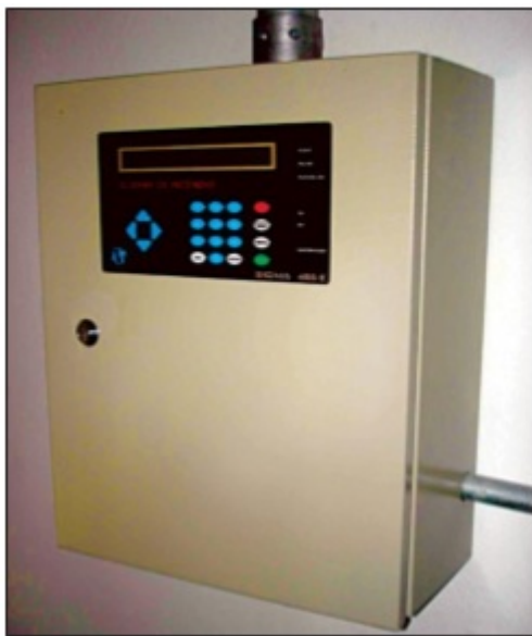
Figura 53: Central de alarme
