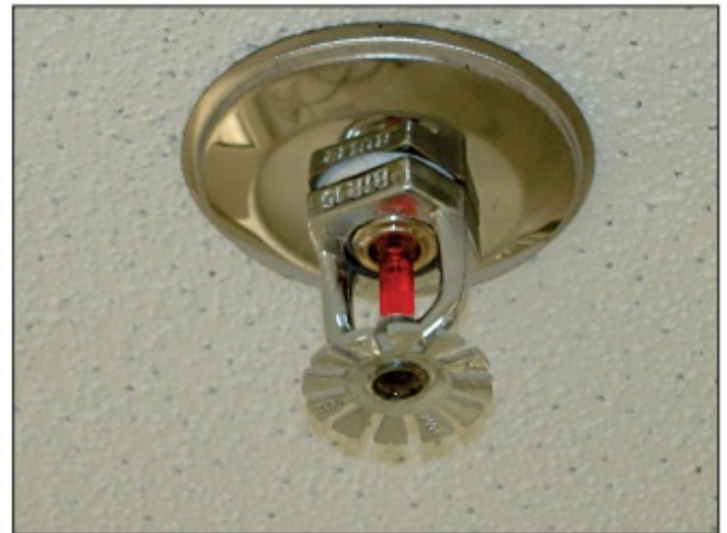
Figura 61: Chuveiro automático
