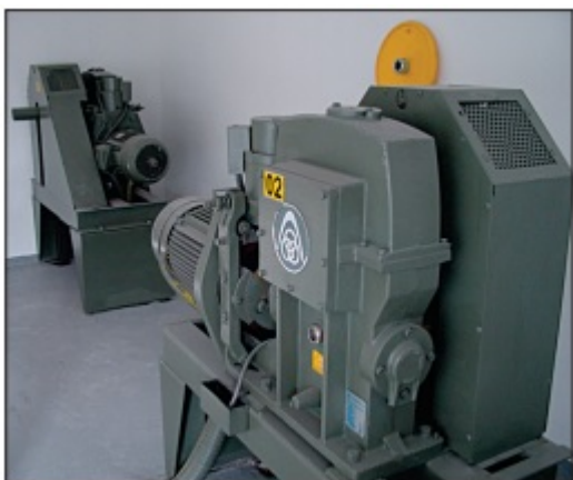
Figura 72: Casa de máquinas dos elevadores
