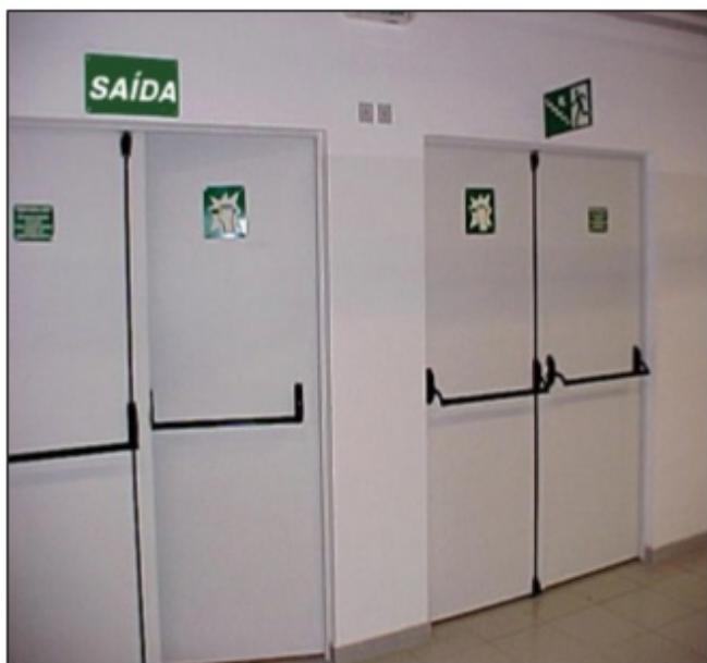
Figura 46: Porta com barra antipânico
