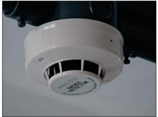
Figura 50: Detector de incêndio
