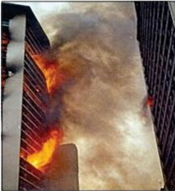
Figura 16: Propagação por convecção, onde gases quentes fazem com que ocorram focos de incêndio em andares distintos
