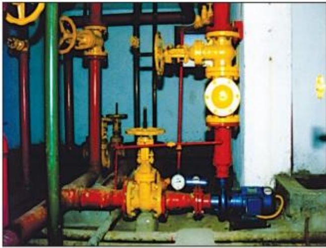
Figura 59: Bomba de incêndio e acessórios hidráulicos
