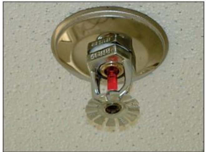
Figura 61: Chuveiro automático
