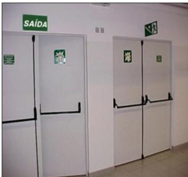
Figura 46: Porta com barra antipânico
