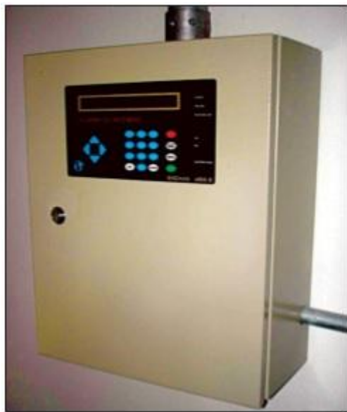
Figura 53: Central de alarme
